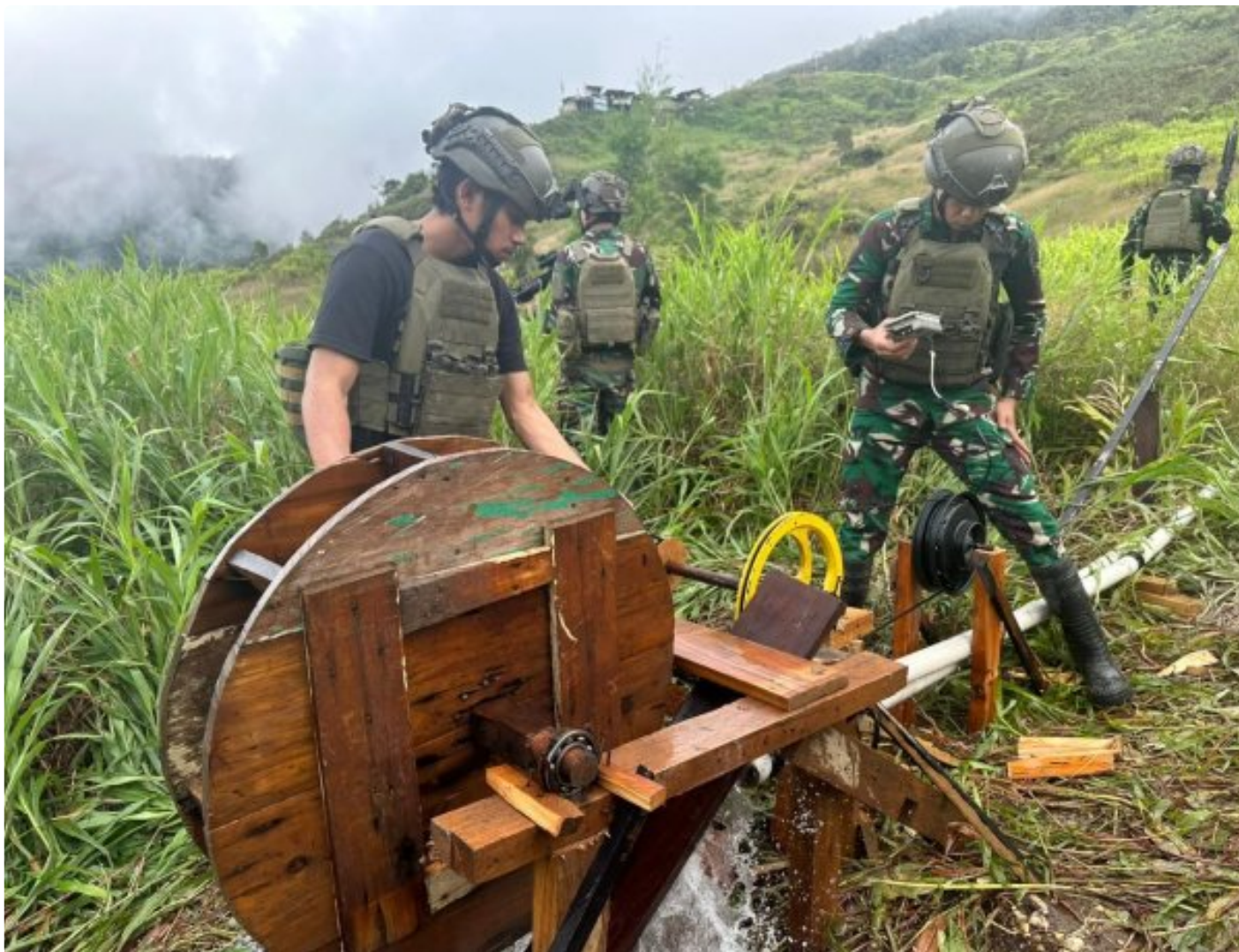
Foto: Saat Prajurit Yonif Linud 432 /WSJ Membuat Pembangkit Listrik Tenaga Air (PLTA) di Distrik Mapenduma, Kabupaten Nduga, Papua Pegunungan, Senin (1/07/2024).
